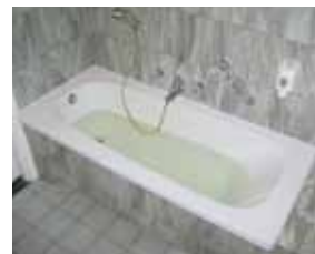
Nieuw bad in bestaande badkamer
