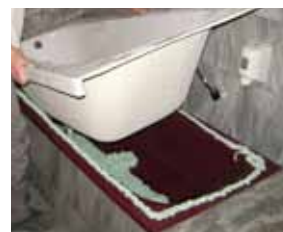
Plaatsing nieuw bad
