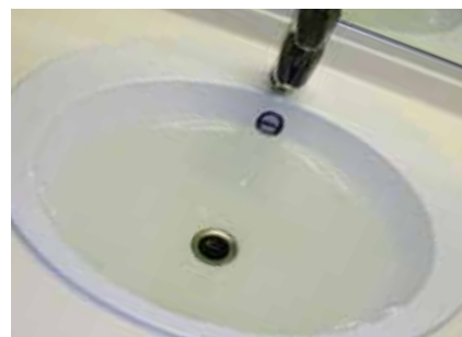
Nieuwe wastafel in bestaand badmeubel
