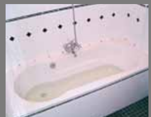
Nieuw bad in bestaande badkamer
